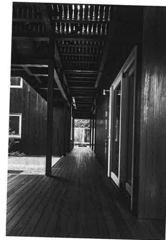
302の前の廊下。スノコ状の床は光と風が抜ける
